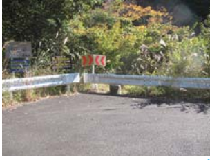
④ 74番 広い ガードレールの 向こうに階段あり
